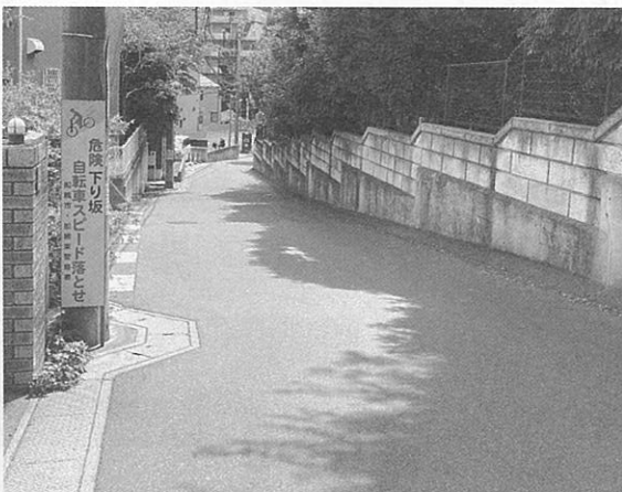
改善事例(中野木2-1:注意看板の設置)
